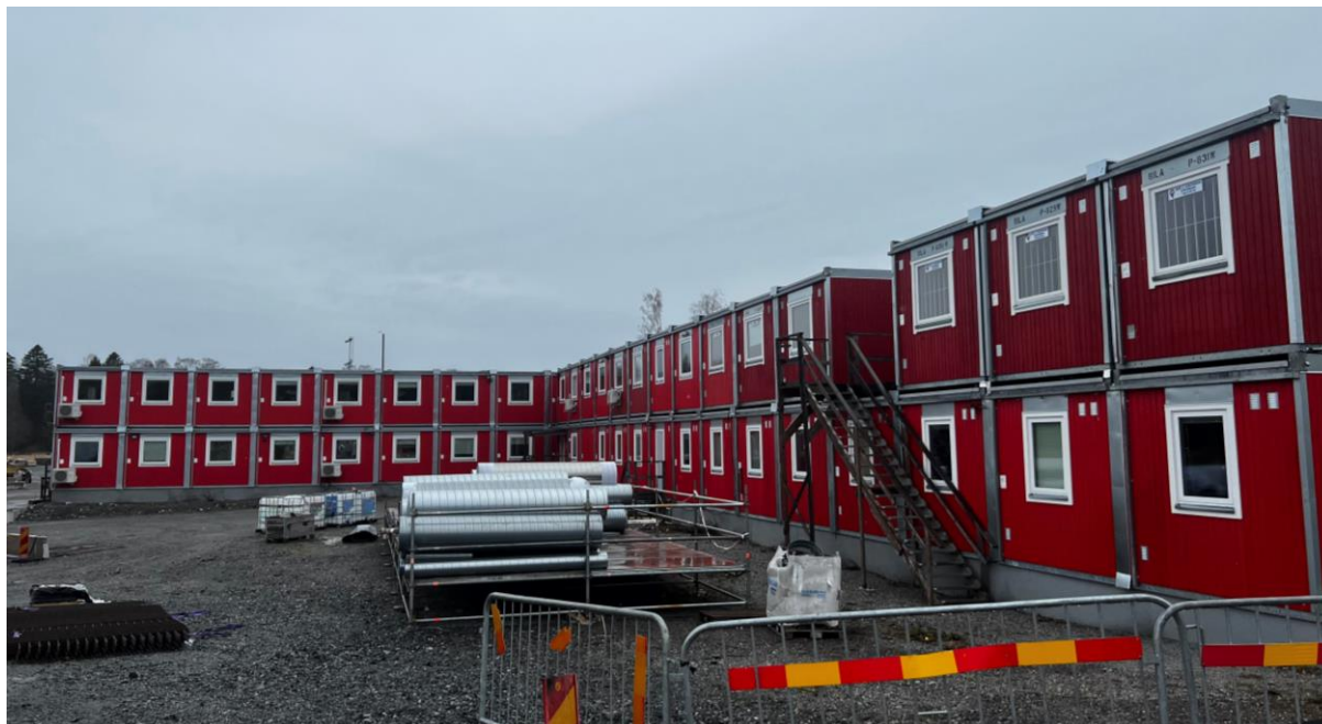
Figur 1. Bodetablering på projektet ”Himmerfjärdsverket”, Grödinge (2024).
