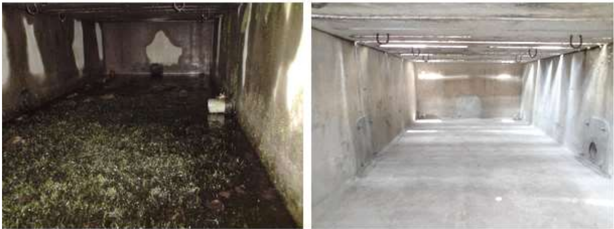
Figur 9. En oljegrop före (vänster) och efter (höger) den rengjorts med ultrarent vatten från Qlean Scandinavia AB.
