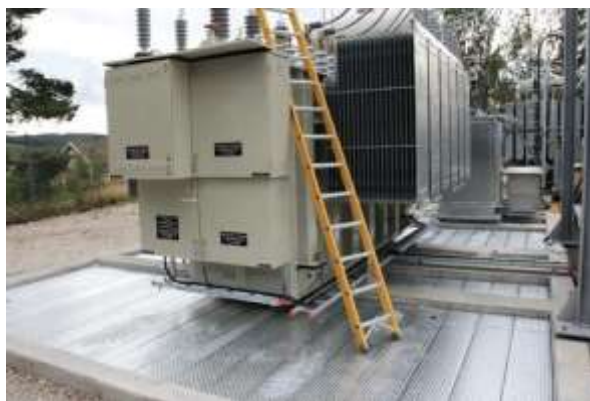
Figur 10. Plåtraster har monterats på oljegropen istället för konventionell släcksten.
